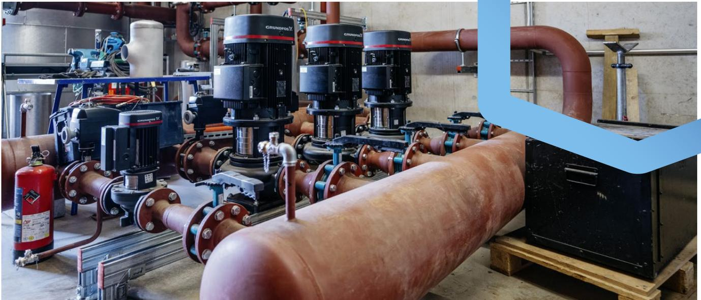
Blick in die Heizzentrale. Diese Pumpen befördern das heisse Wasser in das Transport- und Verteilnetz.
