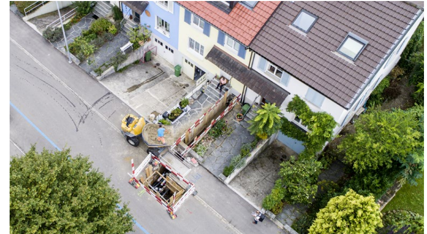
Bau einer Fernwärme-Hausanschlussleitung
