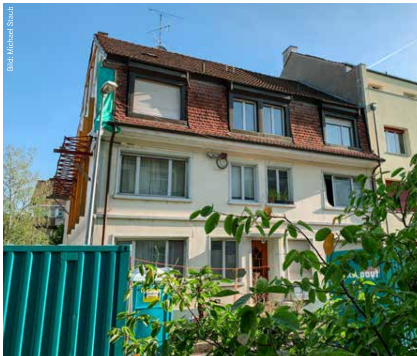
Im Wohnhaus von 1932 in Basel läuft das vielversprechende Pilotprojekt der Industriewerke Basel (IWB). Es konnte rasch und einfach umgerüstet werden; die bisherige Wärmeverteilung samt Heizkörpern ist weiter nutzbar.
