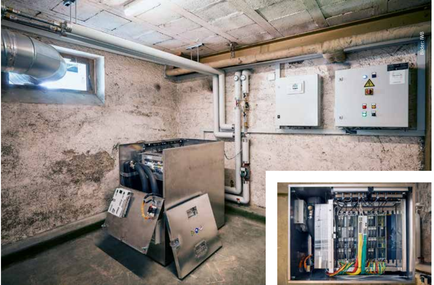
Die unscheinbare Chromstahlkiste im Keller hat es in sich – wortwörtlich: Das Minirechenzentrum im Innern dient nicht nur als dezentrale Serverlösung, sondern gibt über ein Ölbad auch Abwärme ab, die zum Heizen eines Mehrfamilienhauses benutzt wird.
