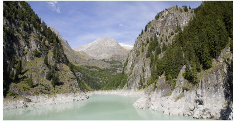
Der Stausee Gibidum im Kanton Wallis staut das Wasser des Grosse Aletschgletschers. Er wird von der Electra-Massa SA zur Stromerzeugung genutzt, an der IWB zu 14% beteiligt ist.
